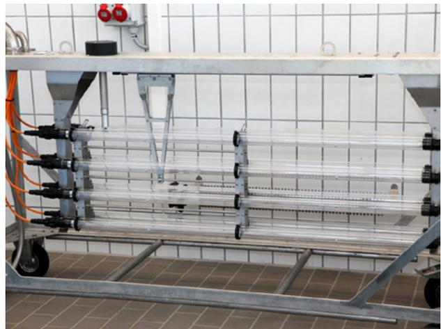
Figura 1: Módulo UV para la desinfección del agua.
